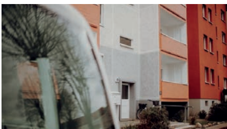
Dock W – Wohnung Außenansicht
